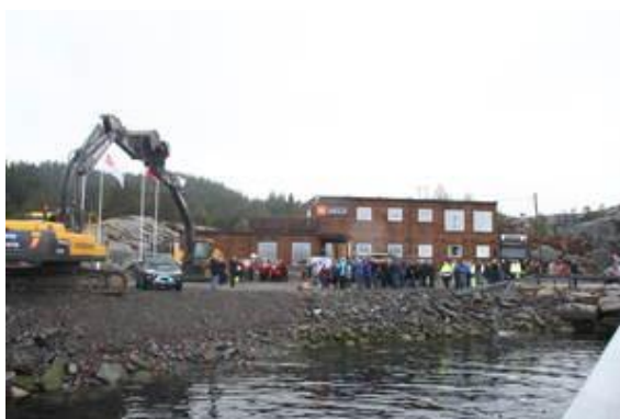
Opning av Skipavika Næringspark
