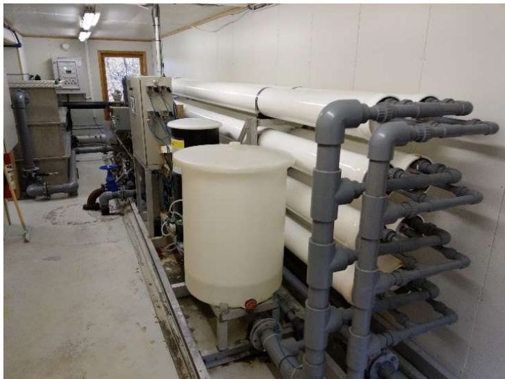
Bilde 1 Vassbehandlingsanlegget ved Eivindvik. Membranfilter til høgre. UV og marmorfilter innerst i rommet ved vindauget
